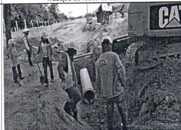
Trabajos de redes de aguas lluvias
