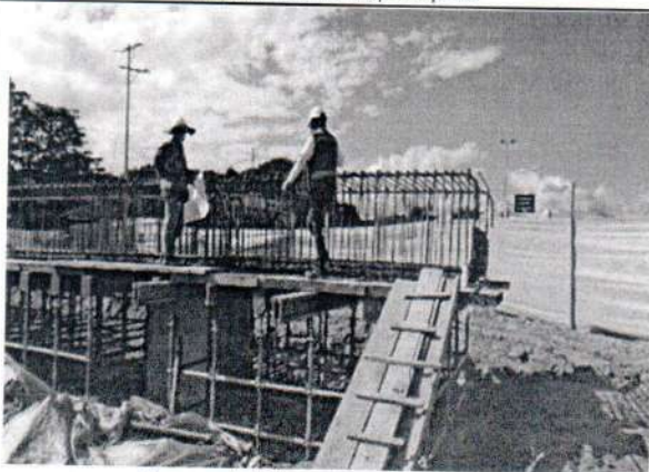
Amarre de hierro para viga cabezal
