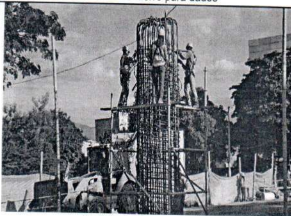
Armado de hierro para pilas
