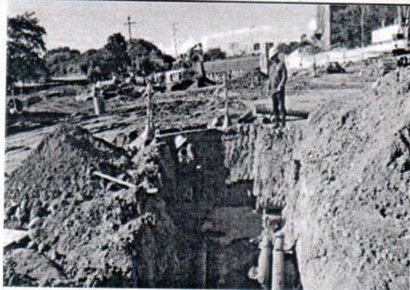
Subterranización de redes eléctricas
