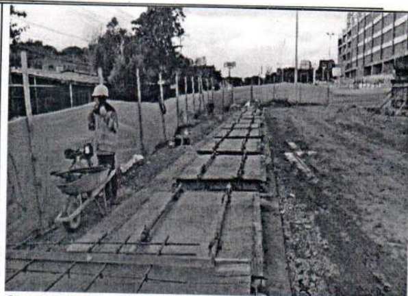
Construcción de placa en concreto para muro en tierra armada
