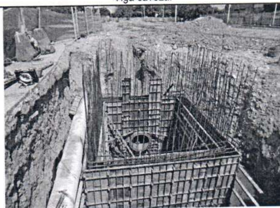
Trabajos de redes de acueducto
