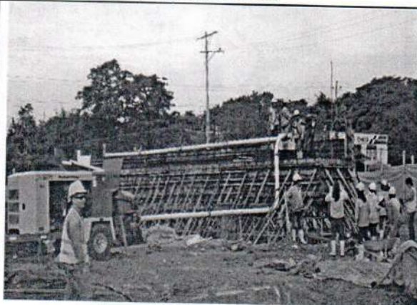
Amarre de hierro para viga cabezal
