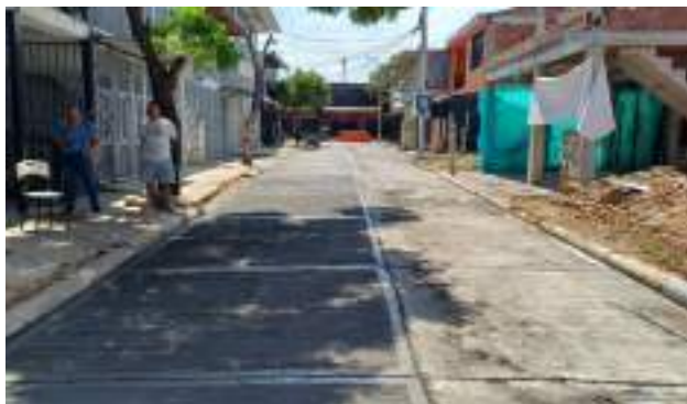
Calle 28 Sur entre carreras 32 y 33 Barrio Tejares del Sur
